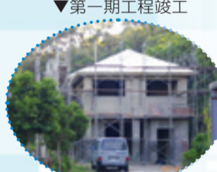
▼第一期工程竣工
